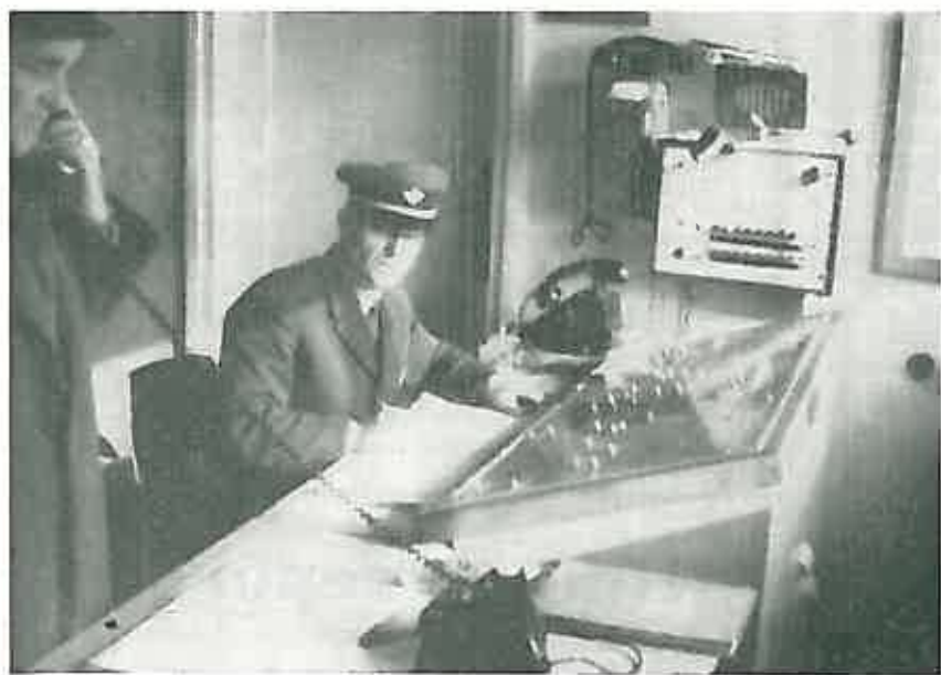
Slika 3. Pored postrojenja za električnu vuču dugoselska stanica je opremljena najsuvremenijim signalnim i manipulativnim uređajima. Prometnik Slavko Klepec sjedi za »komandnim pultom« s kojim manipulira vlakovima. Danas elektronika pomaže prometniku u okretanju skretnica, svjetlosnoj signalizaciji, odjavi i najavi vlakova, zatvaranja i otvaranja brklji, (ah te brklje?).
