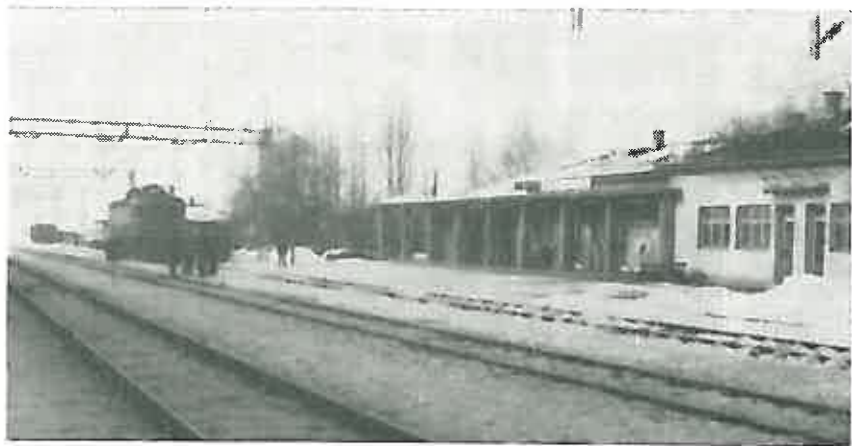
Slika 1. Dugoselska željeznička stanica dočekala je svoju 100. godišnjicu izšarana žicama, čeličnim stupovima i drugim instalacijama danas u Jugoslaviji najmodernije električne vuče.
