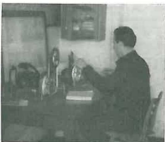
Slika 3. Pored postrojenja za električnu vuču dugoselska stanica je opremljena najsuvremenijim signalnim i manipulativnim uređajima. Prometnik Slavko Klepec sjedi za »komandnim pultom« s kojim manipulira vlakovima. Danas elektronika pomaže prometniku u okretanju skretnica, svjetlosnoj signalizaciji, odjavi i najavi vlakova, zatvaranja i otvaranja brklji, (ah te brklje?).
