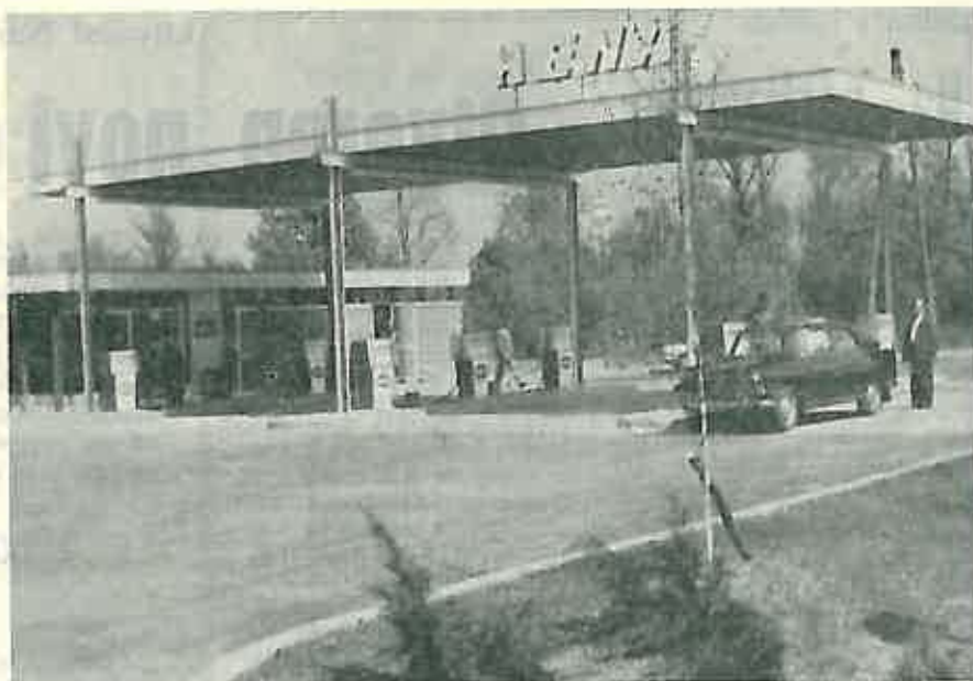
Na raskrslci Dugo Selo — Rugvica i autoputa otvorena je veoma moderna, lijepa i velika benzinska stanica »Hem«.
