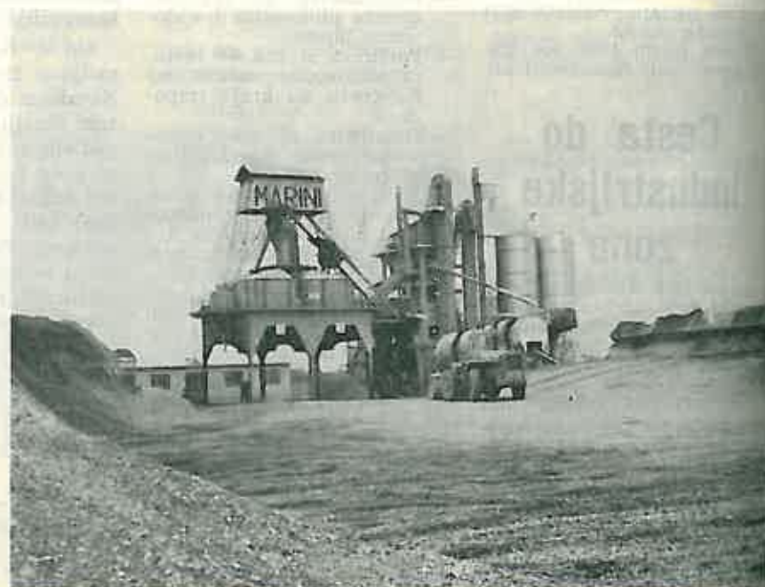
U području oko Trstenika i Svibovskog Otoka pored moderne »Progresove« šljunčare kao gljive posijaje kiše asfaltne baze. Pored stare asfaltne baze »Vladukta« u samom sklopu šljunčare izgrađena je asfaltna baza »Ceste« Zagreb, a na svom ranijem gradilištu »Vladukta« podigao još jednu modernu asfaltnu bazu.
