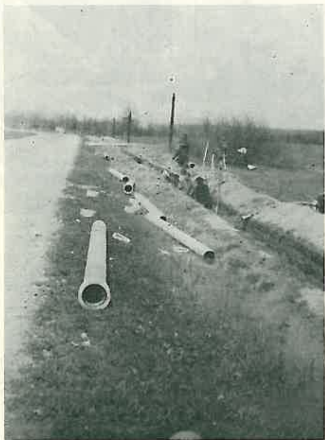
Polaganje vodovoda za Rugvicu — Institut za oplemenjivanje bilja. Ova vodovod pored Instituta koristit će i našim selima ispod autoputa i u Posavini, jer na taj način dobivaju mogućnost priključka na vodovod.
