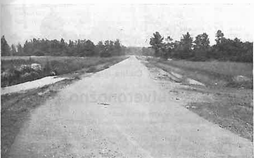
Dio već potpuno izgrađene ceste sa suvremenim kolovozom koja će već sutra spojiti auto-put sa selom Preseka.
