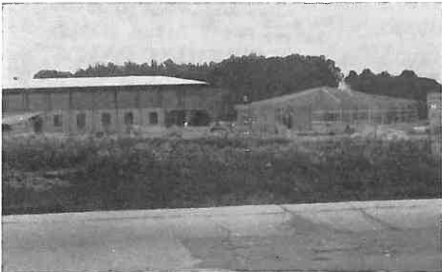
O »Risnjakovom« hotelu na autoputu u Ježevu dugo se pričalo, sada se ubrzano radi. Dok smo u prošlom broju objavili čeličnu konstrukciju objekta, danas je to razvijeno gradilište.
