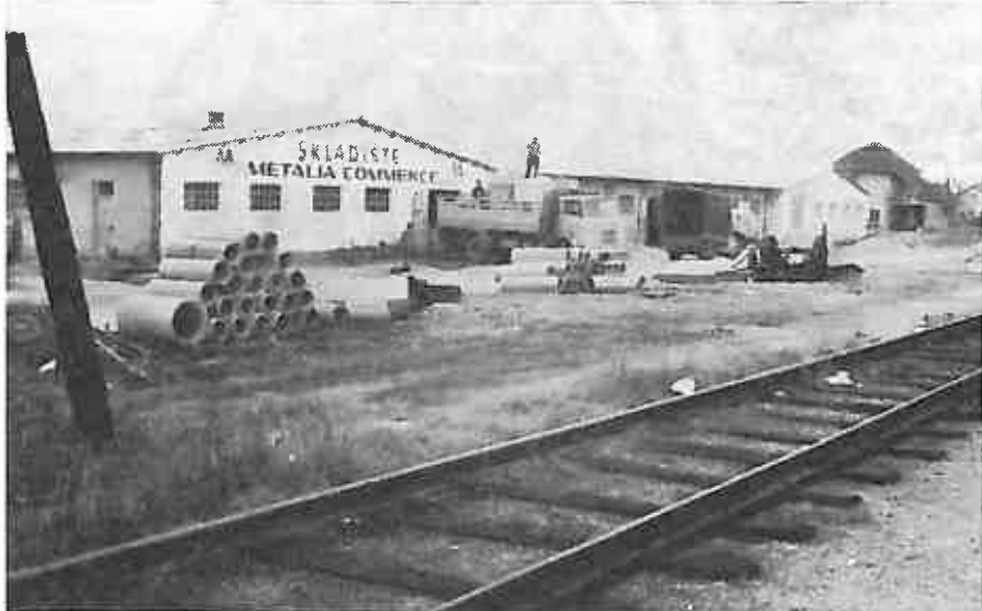
Pripremni radovi na izgradnji skladišnog prostora za prodaju automobila marke »Citroen« - »Tomos« u Dugom Selo.
