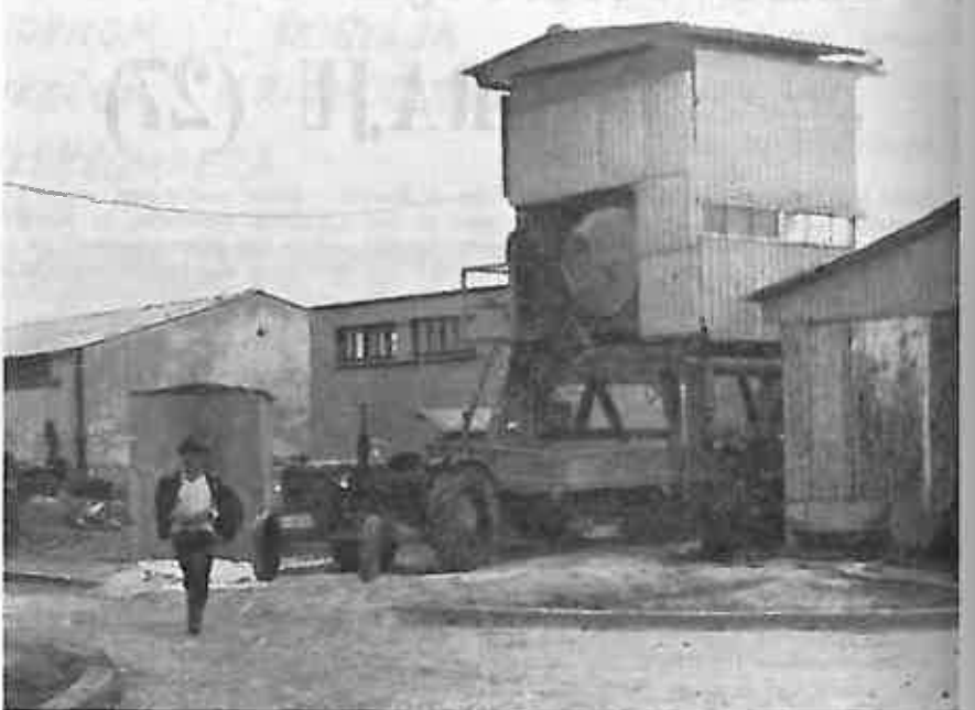
Koliko će se ugraditi betona najbolje govori podatak da betonjara na slici dnevno preradi 100 kubika šljunka.
