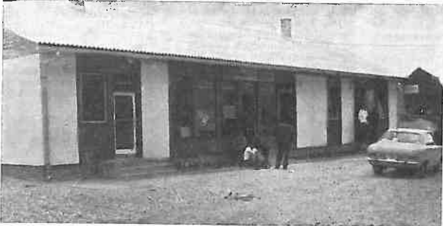
Iako više nije gradilište, ali je novo izgrađen trgovačko ugostiteljski objekat »Budućnost« u Brekovljanima.
