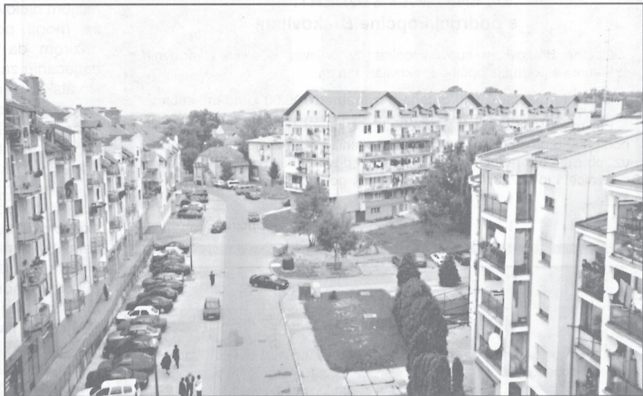
Novim planom zona Centar trebala bi dobiti izgled i funkcionalnost gradskoga središta
