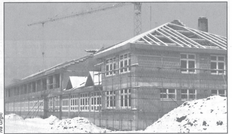
Radovi na izgradnji rugvičke škole dosada su tekli prema planu
