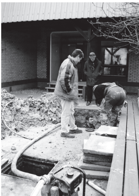
Dukomove ekipe saniraju lom vodovodnih cijevi ispred Policijske postaje Dugo Selo
